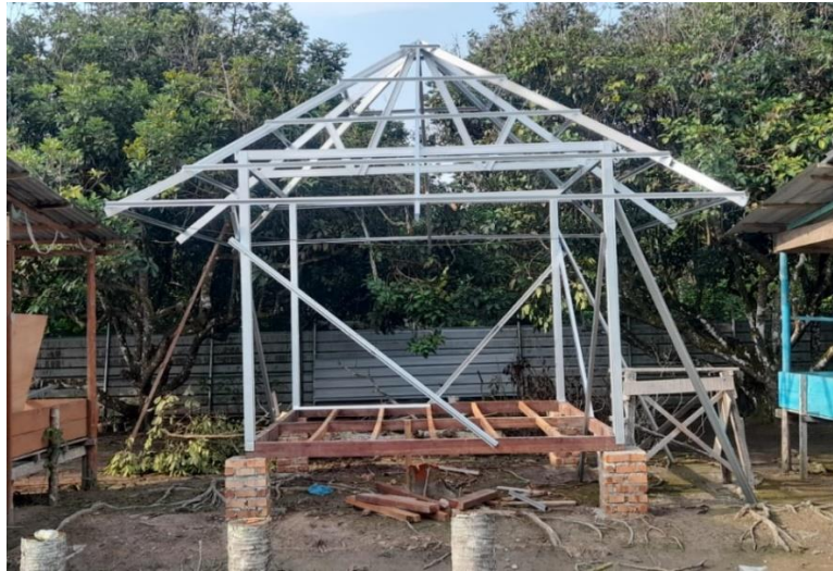
Gambar 3.1 Konstruksi Gazebo Baca Baja Ringan
