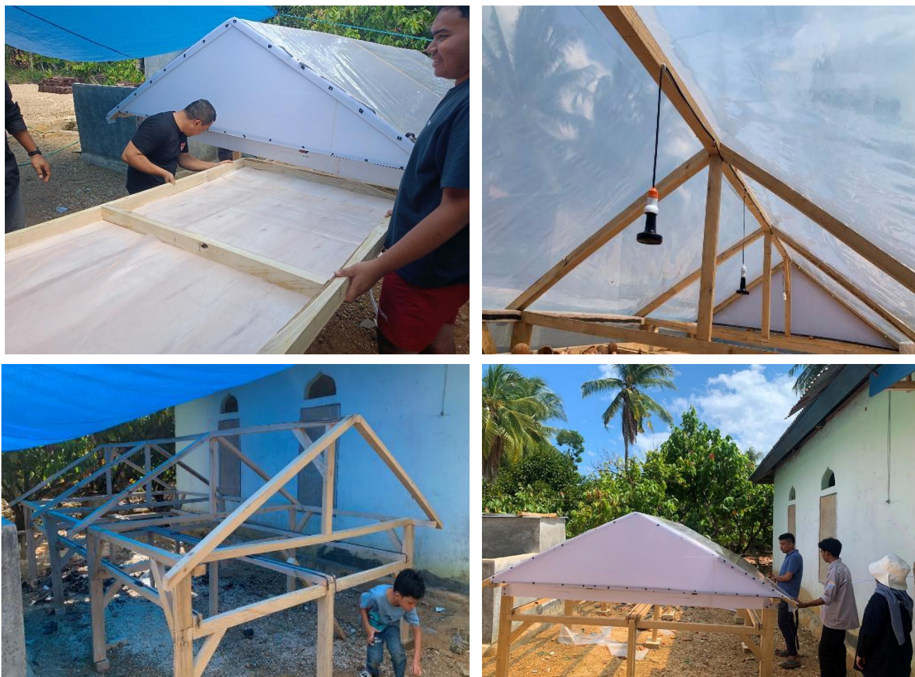
Gambar 2 Proses Pembuatan Alat Pengering Kopra dengan Teknologi ERK
