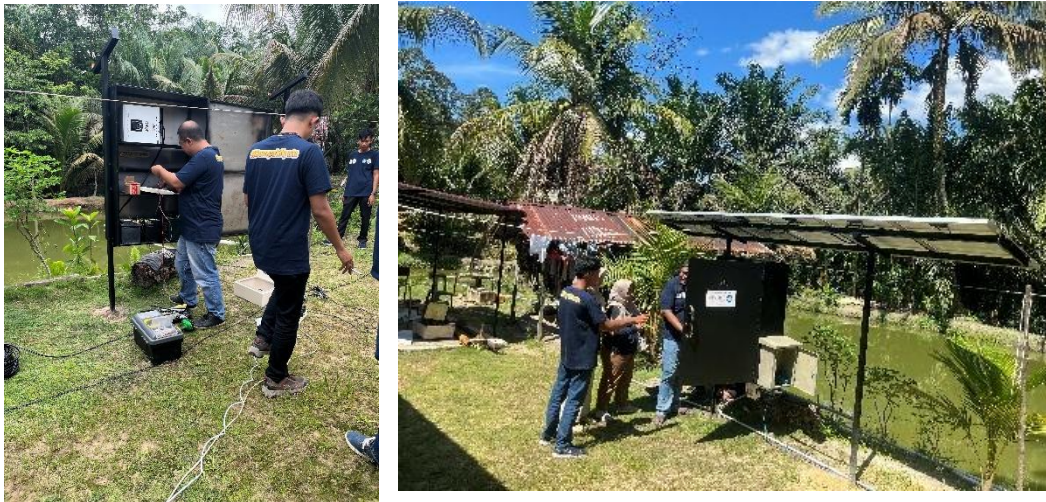
Gambar 1. Pemasangan Sistem IoT Sensor pH dan Suhu
