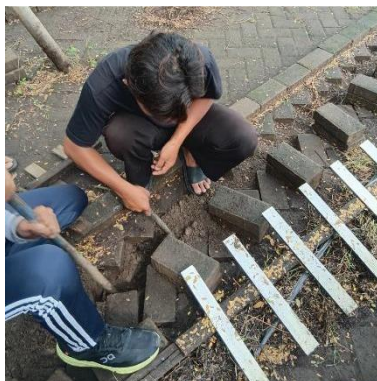
Gambar 4. Pemasangan Pagar di Setiap Wilayah
