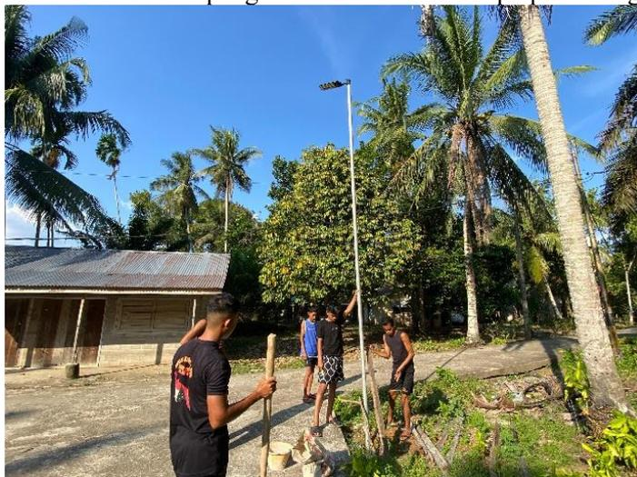
Gambar 3. Proses Pengecoran tiang pada titik yang telah ditentukan
